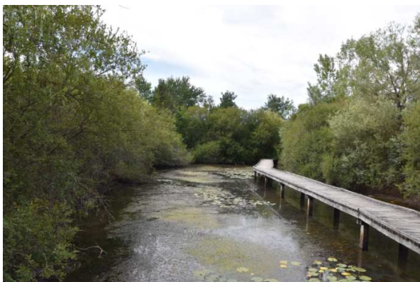
Drewniana kładka poprowadzona na palach, kładki można również umieszczać na pływakach.
