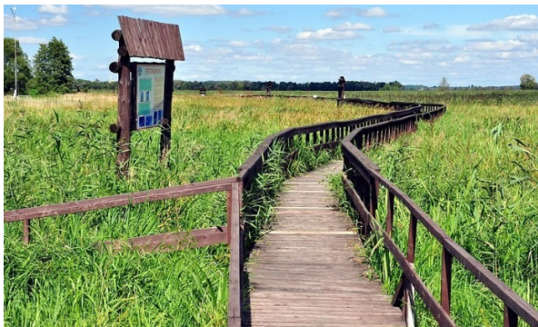
Drewniane kładka umieszczona na palach w trzcinowisku ( www.ciekawepodlasie.pl )
