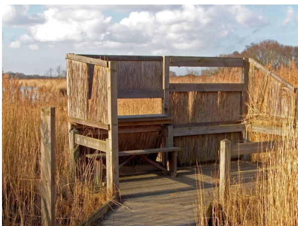
Drewniano-trzcinowa czatownia, widok od strony dojścia kładką (wersja bez dachu).
