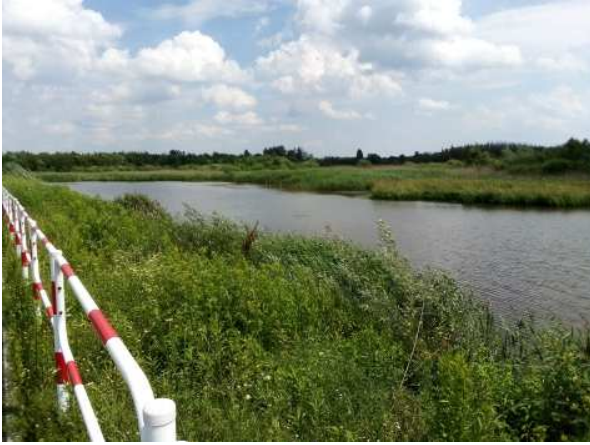
Fot. 9. Zbiornik 3B od strony ul. Chemików (27.06.2020)
