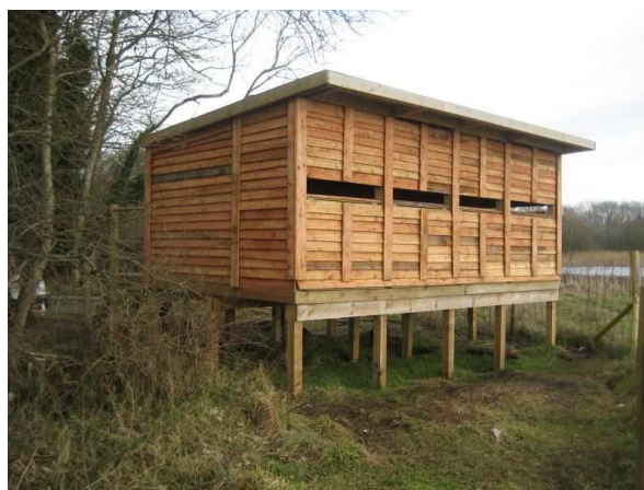
Drewniana czatownia na palach, widok od strony zbiornika (wersja z dachem).
