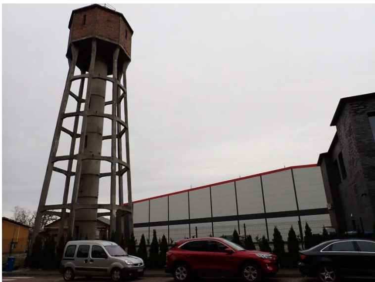
Fot. 3 Widok na zabytkową wieżę ciśnieniową na terenie zakładu NITROERG S.A.
