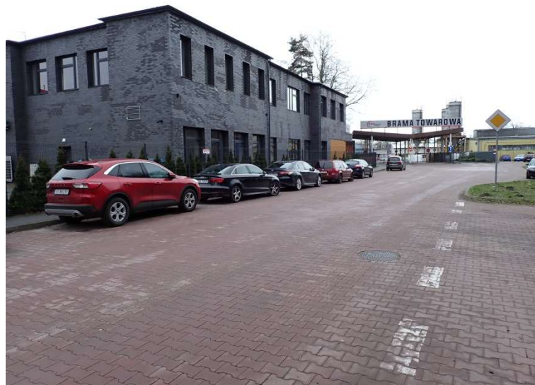
Fot. 4 Widok na bramę towarową oraz zabudowania zakładu ERG Bieruń - Folie Sp. z o.o.
