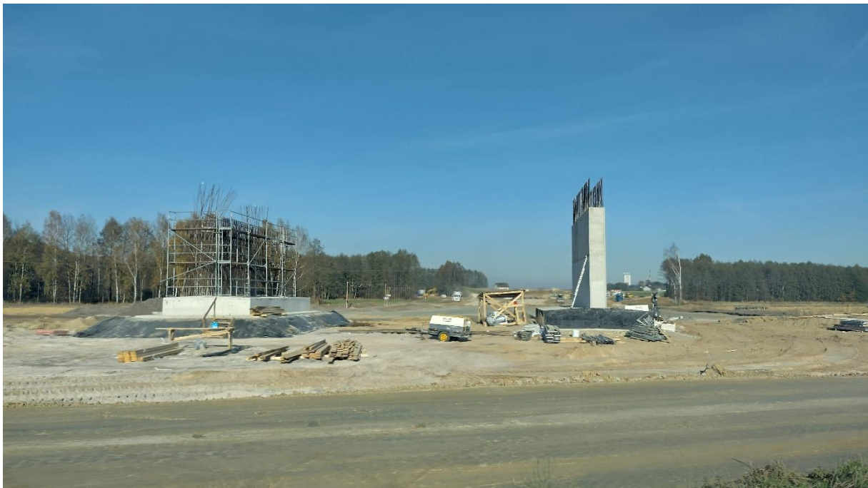
Zdjęcie 1. 40. Widok na teren budowy trasy ekspresowej S1 w rejonie ul. Bijasowickiej
