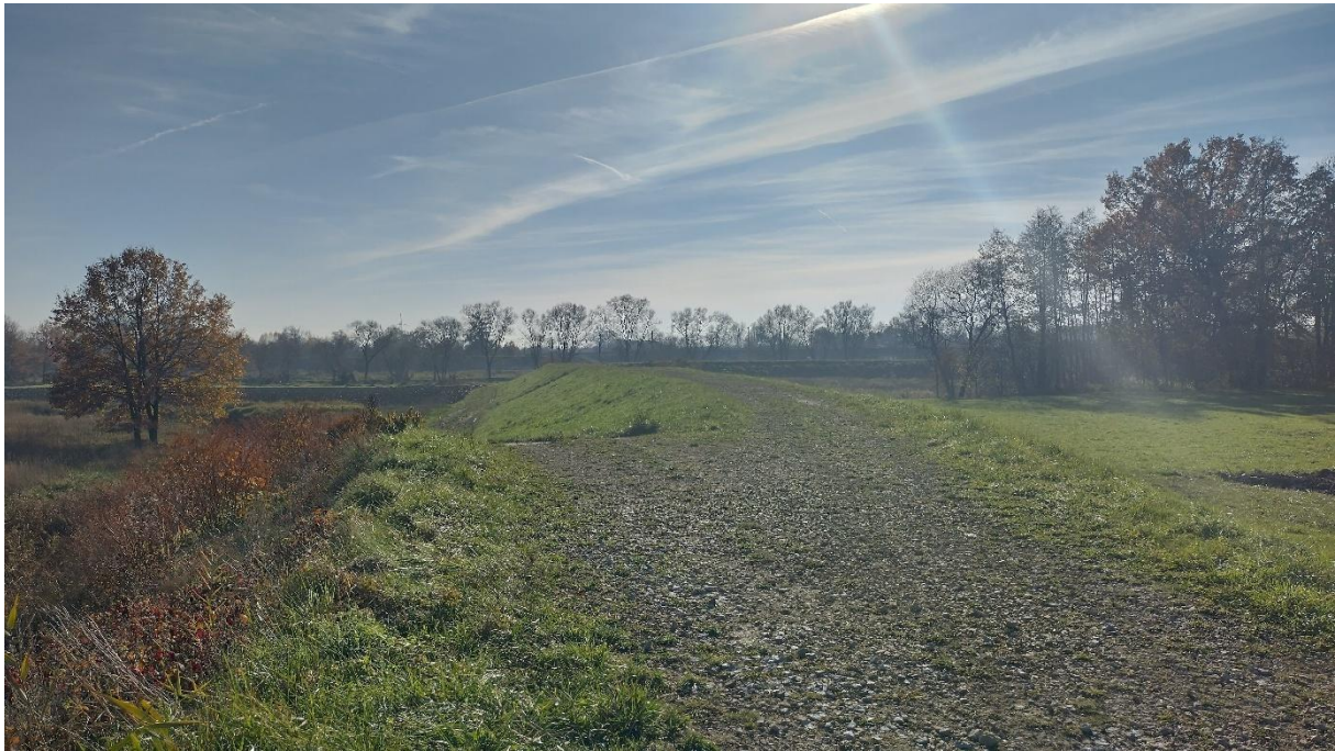
Zdjęcie 1. 21. Obwałowanie Potoku Goławieckiego
