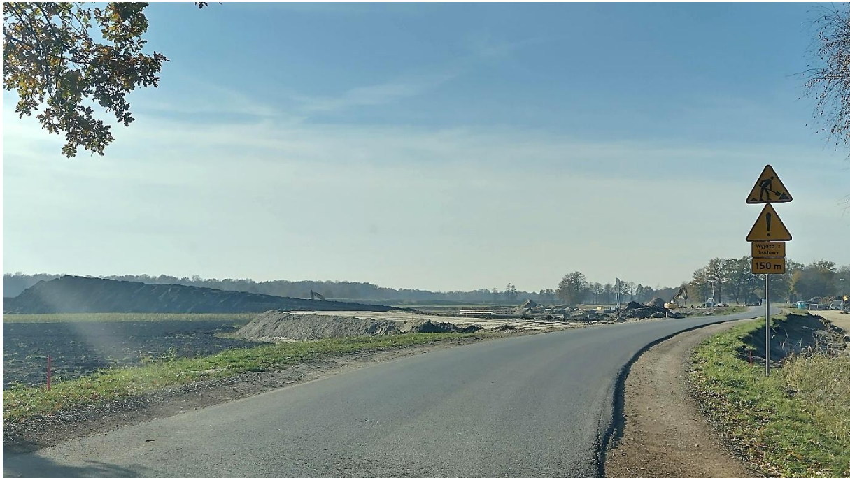
Zdjęcie 1. 39. Widok na teren budowy trasy ekspresowej S1 w rejonie ul. Bijasowickiej
