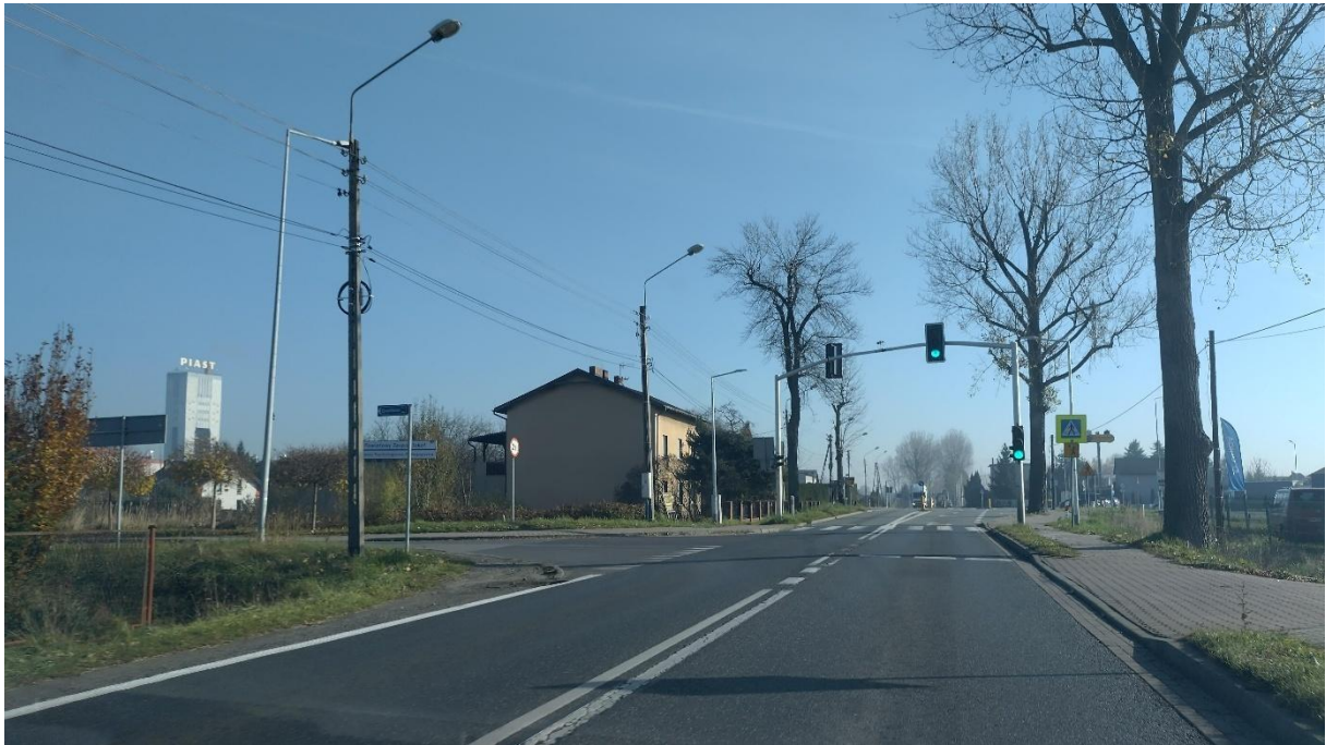
Zdjęcie 1. 11. Skrzyżowanie ulic Warszawskiej i Granitowej – w tle kopalnia „Piast-Ziemowit”
