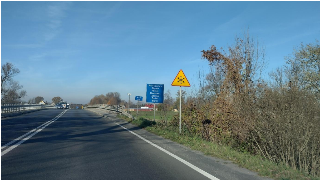
Zdjęcie 1. 17. Most nad rzeką Wisłą przy wjeździe do Bierunia
