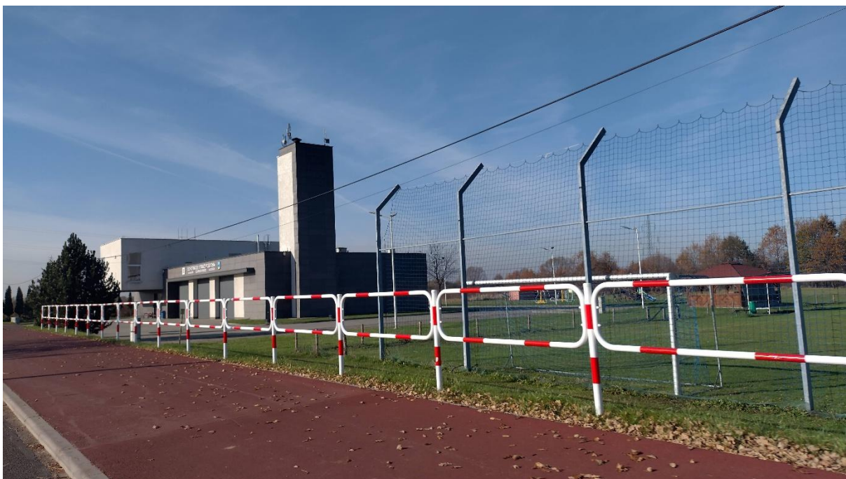
Zdjęcie 1. 28. Budynek Ochotniczej Straży Pożarnej w Czarnuchowicach
