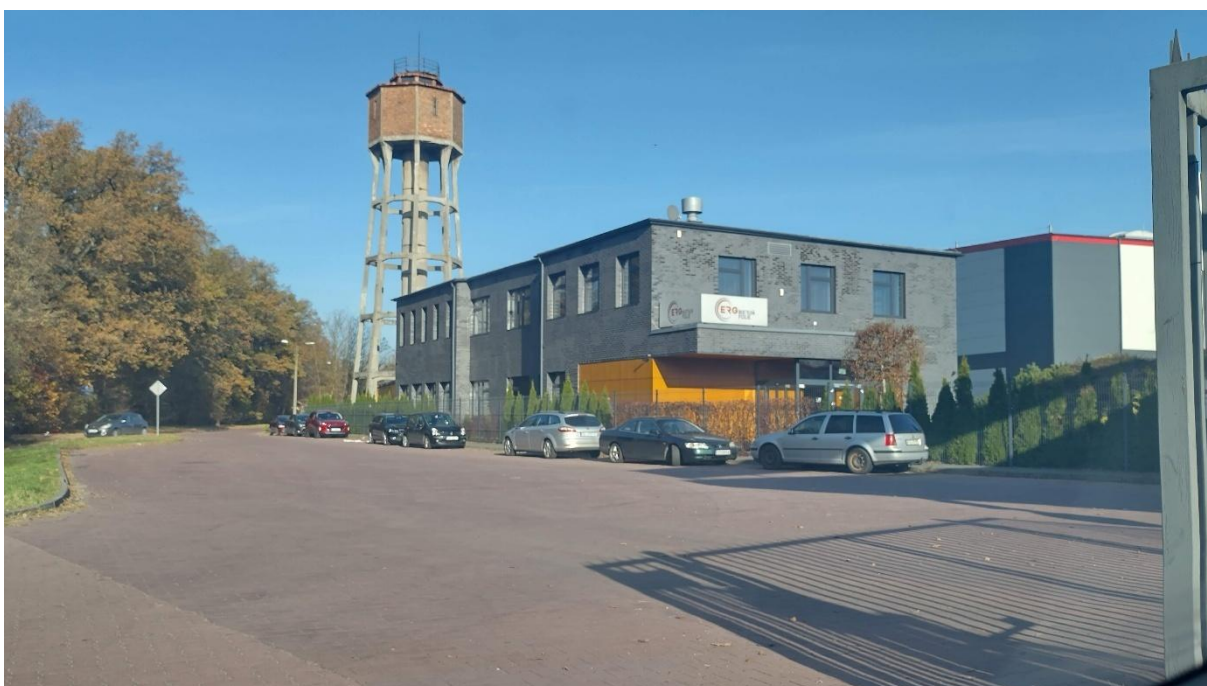
Zdjęcie 1. 54. Budynki produkcyjne przy ulicy Chemików
