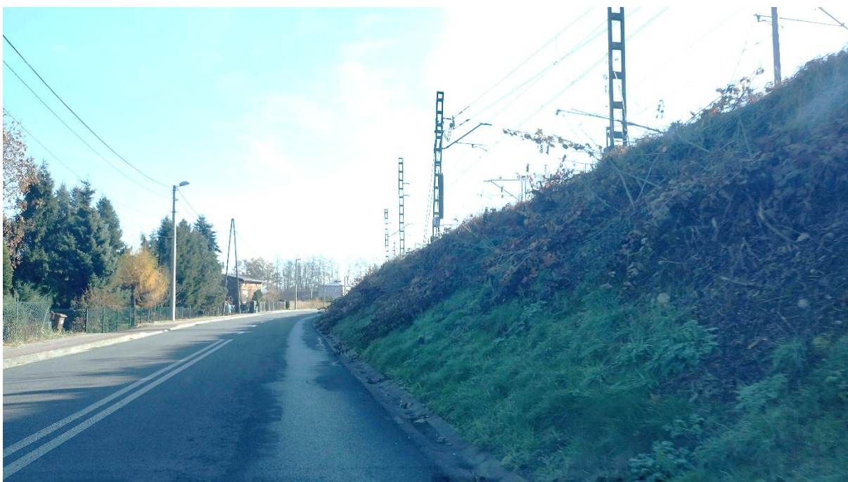
Zdjęcie 1. 20. Nasyp kolejowy przy ul. Bohaterów Westerplatte
