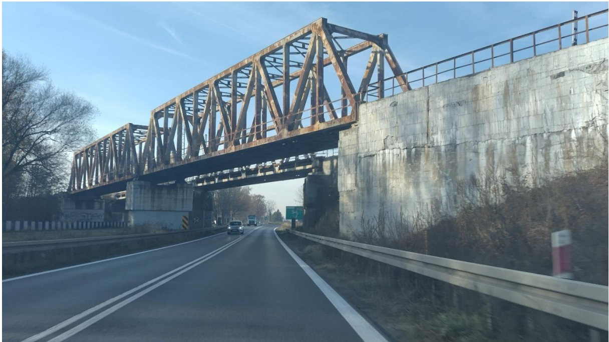
Zdjęcie 1. 49. Wiadukt kolejowy przy ulicy Warszawskiej
