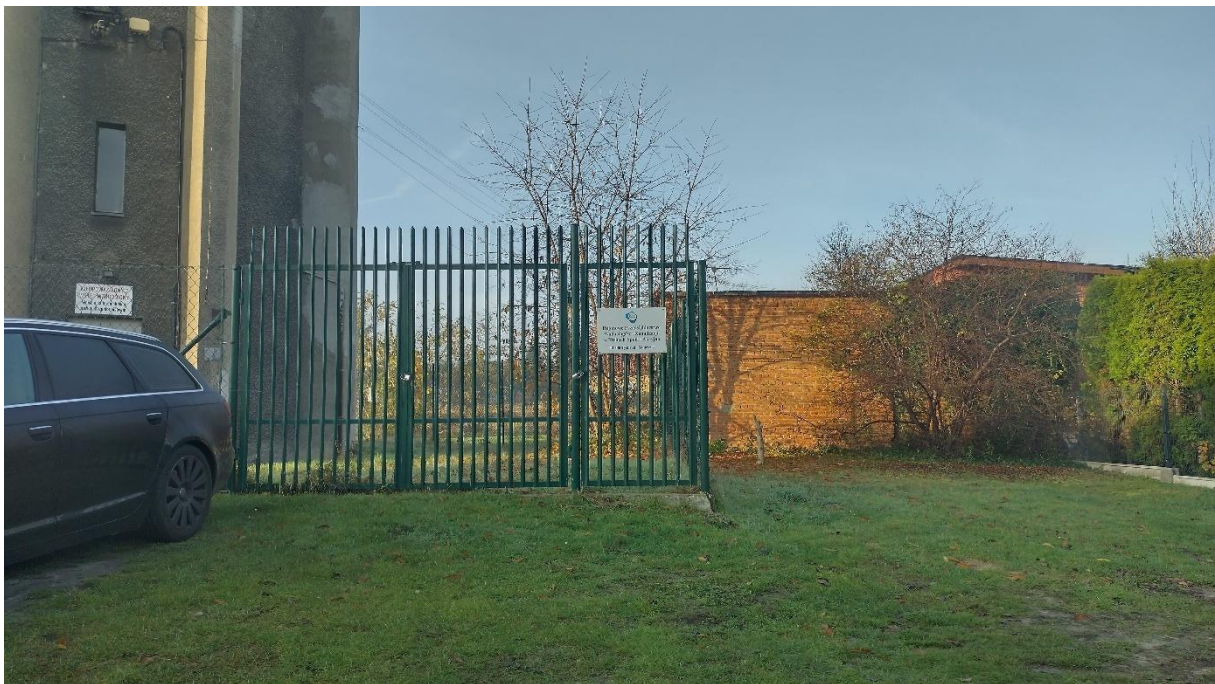
Zdjęcie 1. 6. Infrastruktura techniczna (wodociągowa) przy ul. Klasztornej
