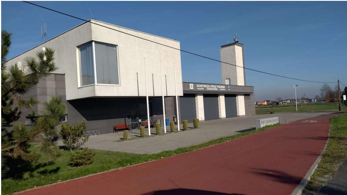
Zdjęcie 1. 29. Budynek Ochotniczej Straży Pożarnej w Czarnuchowicach
