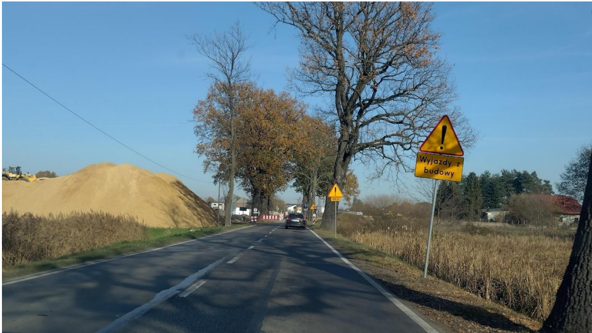
Zdjęcie 1. 45. Wyjazd z terenu budowy (przebudowy) DK44 w rejonie ul. Turystycznej
