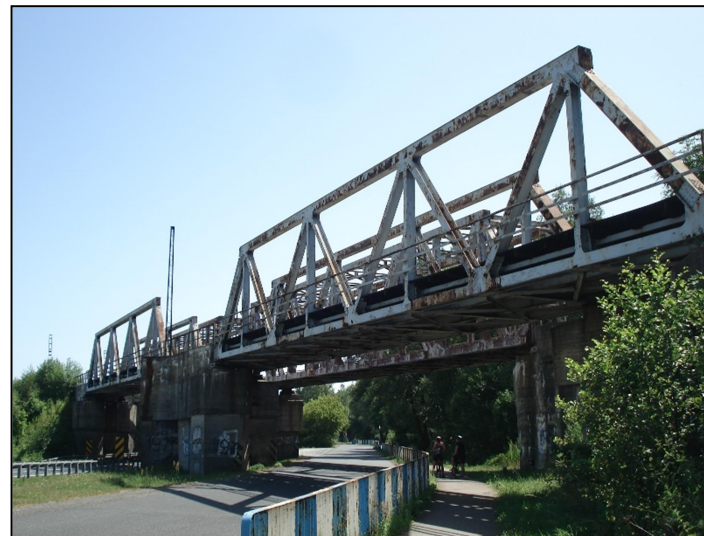
Fot. 15 Wiadukt na ul. Turyńskiej, południowa granica obszaru
